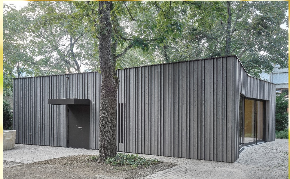
Neubau Pavillon Dorfkirche Kleinhüningen ETERNO FASSADENGRAU
